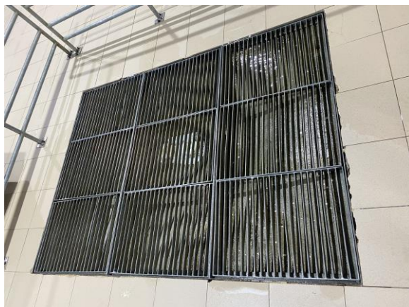
Сл.36:Бетонска јама у унутар објекта
