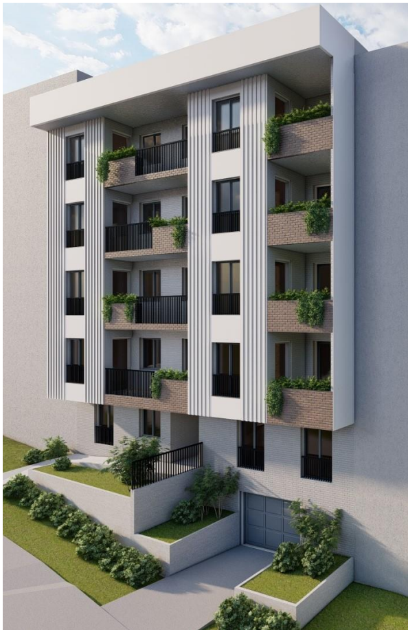
Сл.3 Изглед предње фасаде
